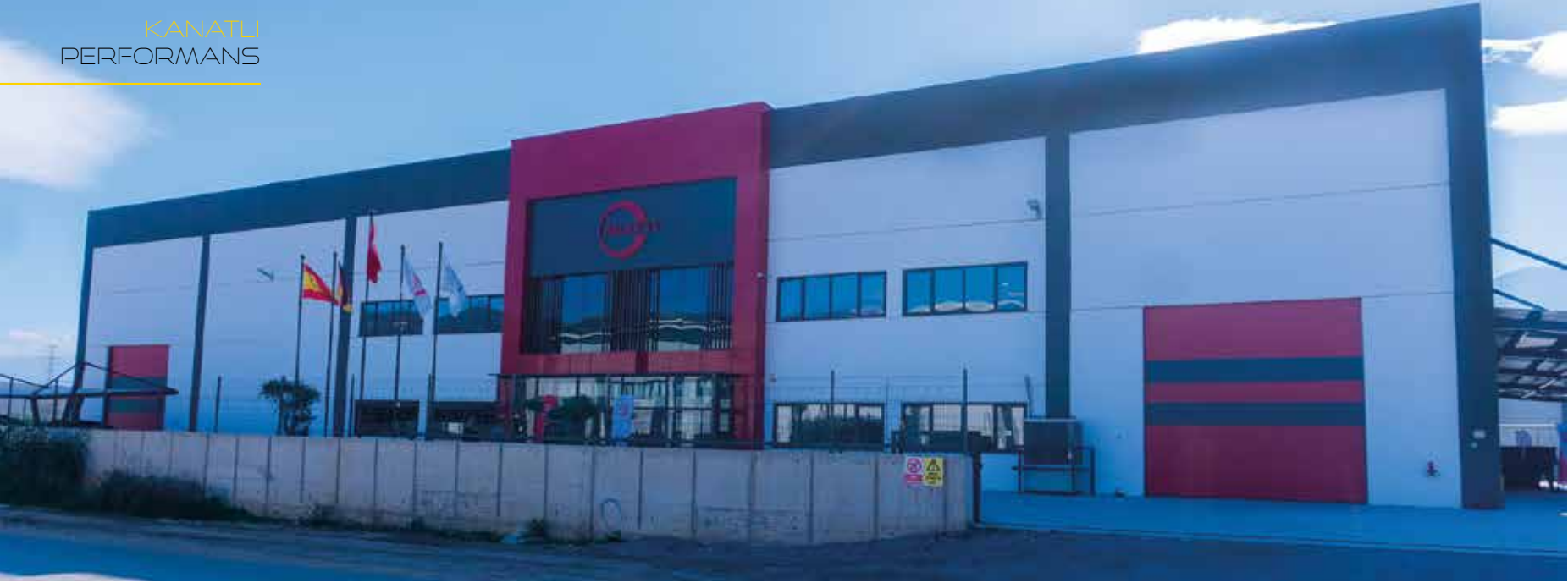
Miavit Türkiye İzmir Kemalpaşa'daki merkez binası ve üretim yeri.
